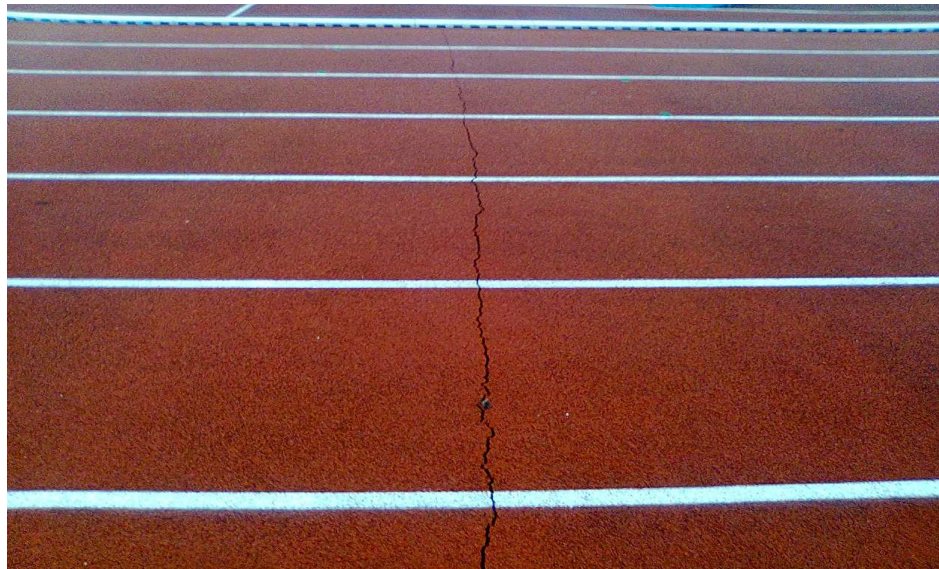
Fot. 1 Peknięcie bieżni
